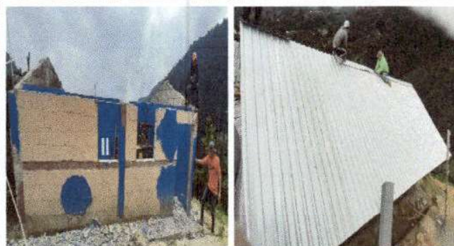
Foto 2: Sustrucion de lámina, por lámina troquelada aluzinc
