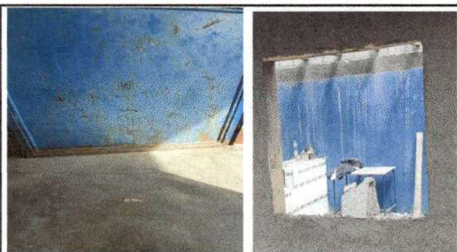
Foto 3: mantenimiento a estructura y sustrucion de ventana de madera por metal mas vidrio
