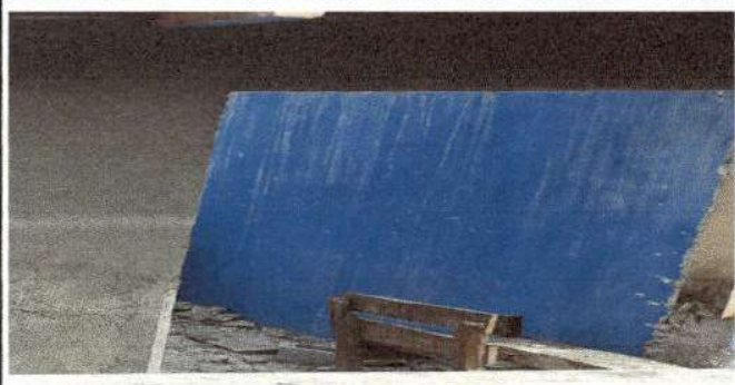
Foto1: Sustrucion de puerta de madera por metal
