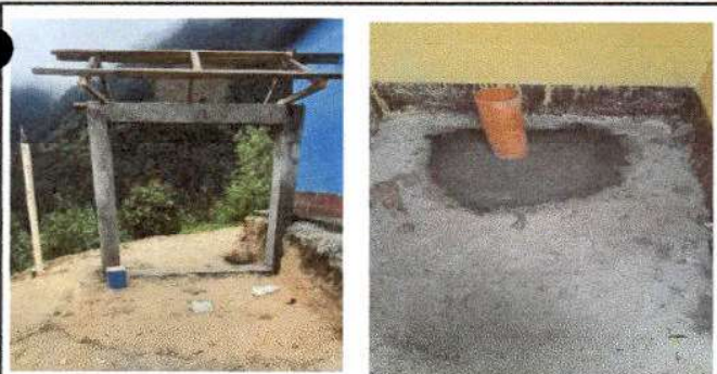
Foto 5: Sustrucion de porton e Inodoro
